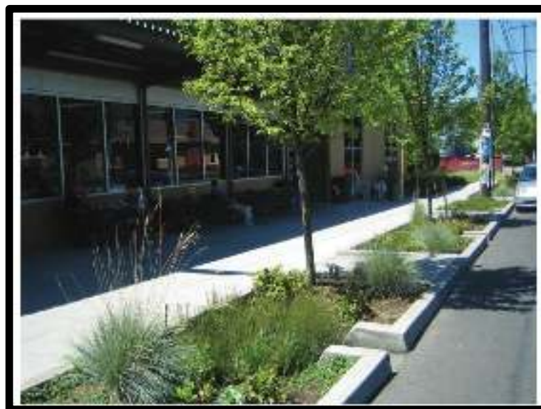
Figura 13: Canteiros pluviais junto do New Seasons Market, em Portland, Oregon - Foto: Nathaniel S. Cormier (Fonte: Cormier e Pellegrino, 2008)
