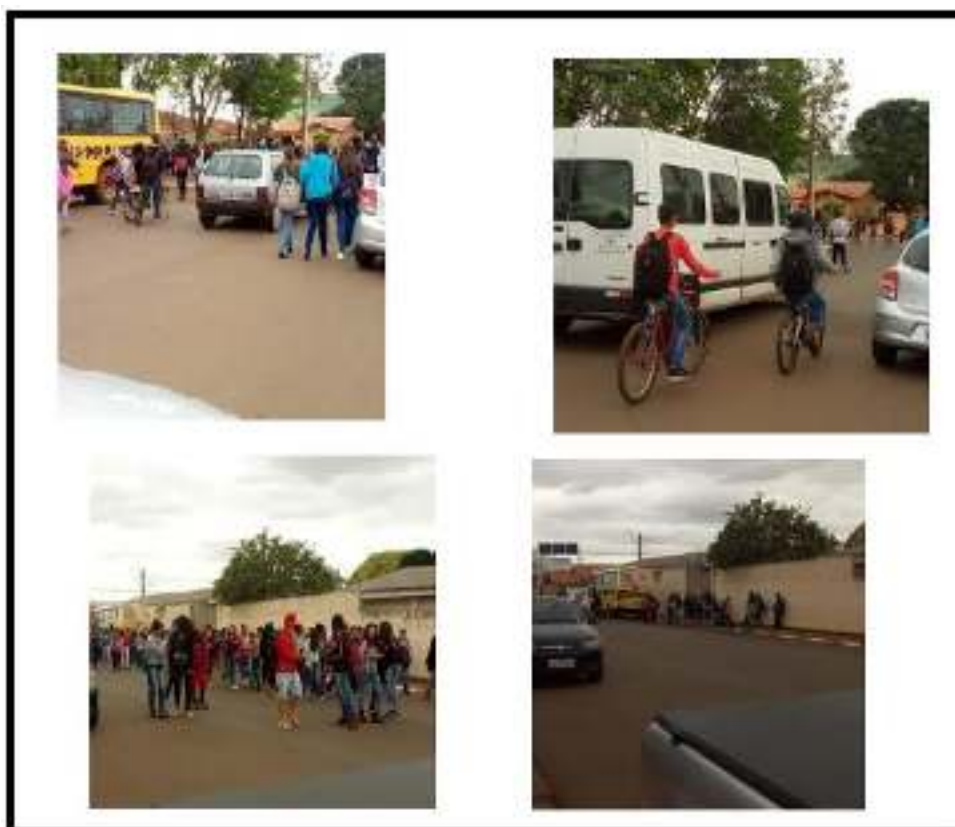
Figura 28: Falta de sinalização próximo a escola
