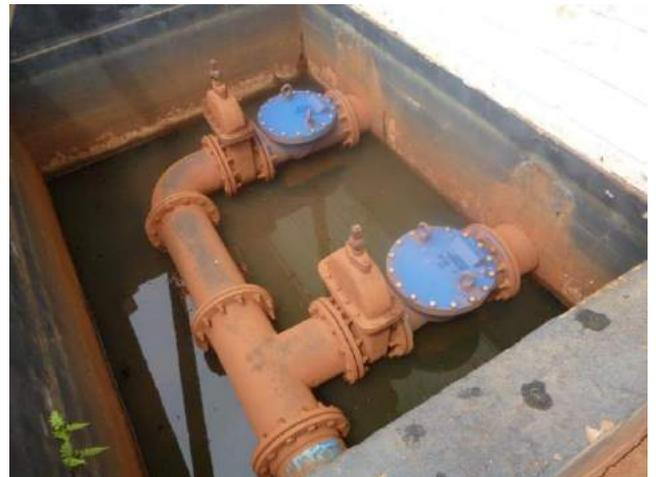
Foto 4.10 - Poço de sucção – EEE Final
