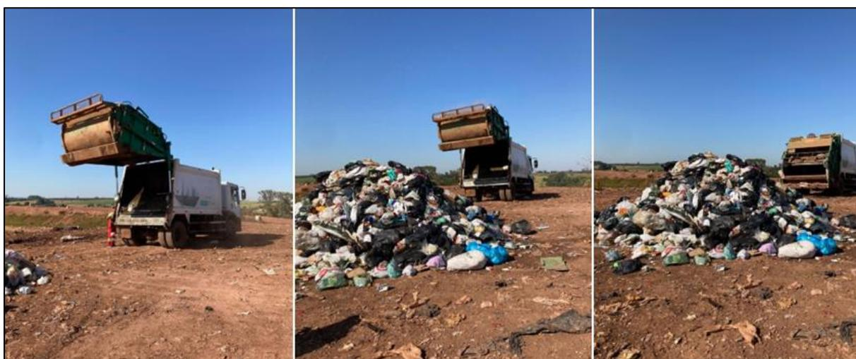
Figura 20 - Sequência do descarregamento dos resíduos sólidos urbanos antecedendo as etapas de preparação do estudo gravimétrico.
