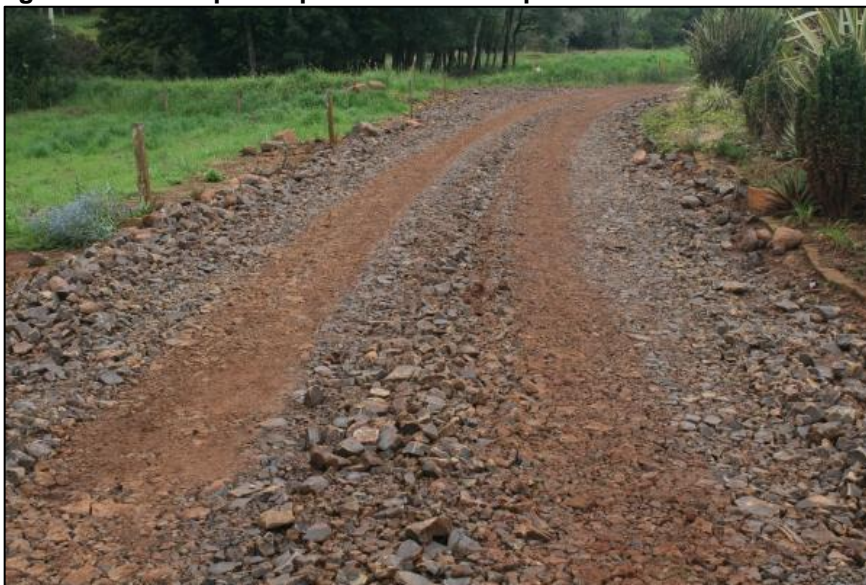
Figura 68 – Exemplo de pedras utilizadas para o melhoramento da via.
