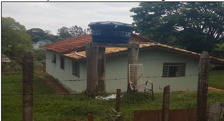
Figura 45 – Exemplo de reservatório elevado e ligado a encanamentos.
