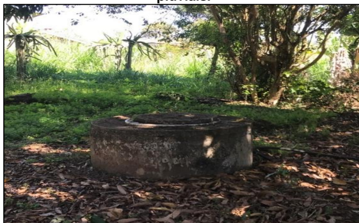
Figura 44 – Exemplo de poço com altura na abertura visando impedir entrada de águas pluviais.
