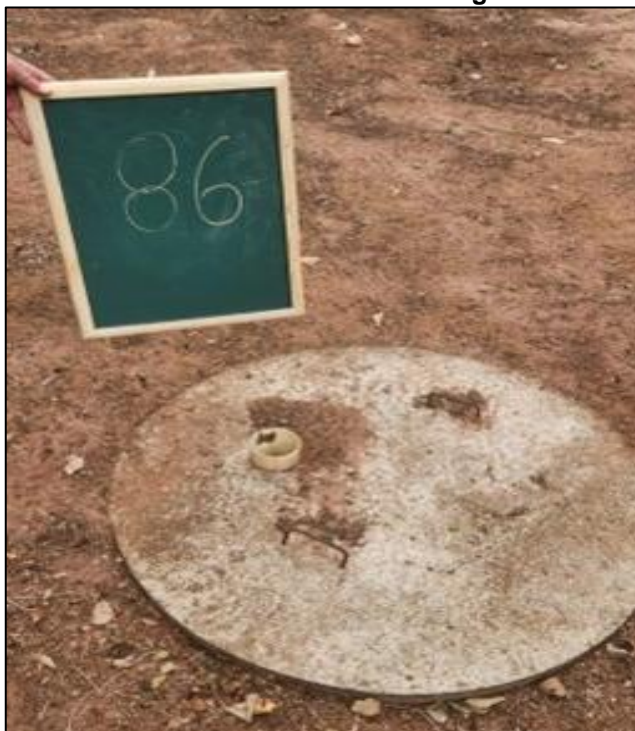
Figura 56 - Fossa séptica bem vedada em Engenheiro Coelho – Grupo 07. (Coordenada: Latitude: 22°29'24.61"S – Longitude: 47° 6'8.12"O)
