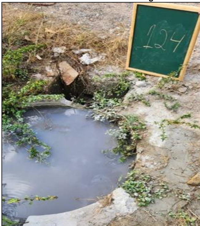
Figura 49 - Fossa a céu aberto identificada. (Coordenada: Latitude: 22° 31' 11.95"S – Longitude: 47° 8' 4.38"O)
