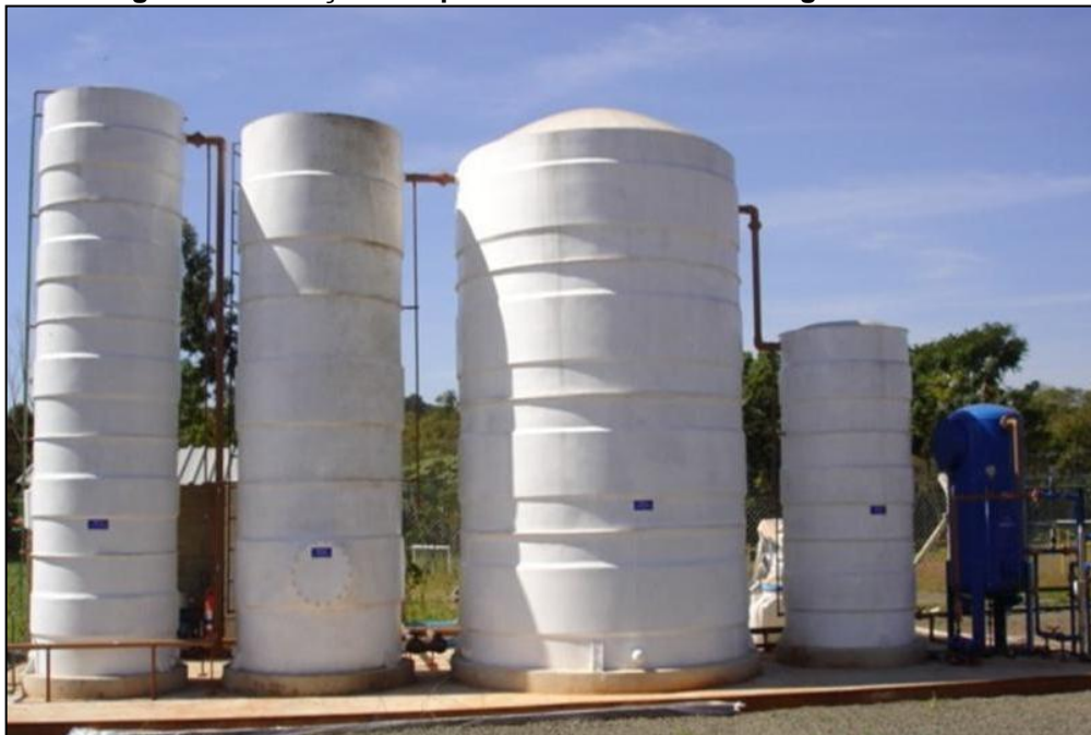
Figura 80 - Estação compacta de tratamento de esgoto sanitário.
