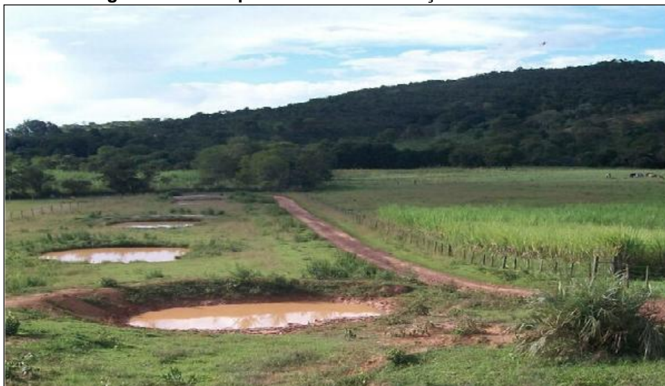
Figura 91 - Exemplo de bacia de retenção em área rural.
