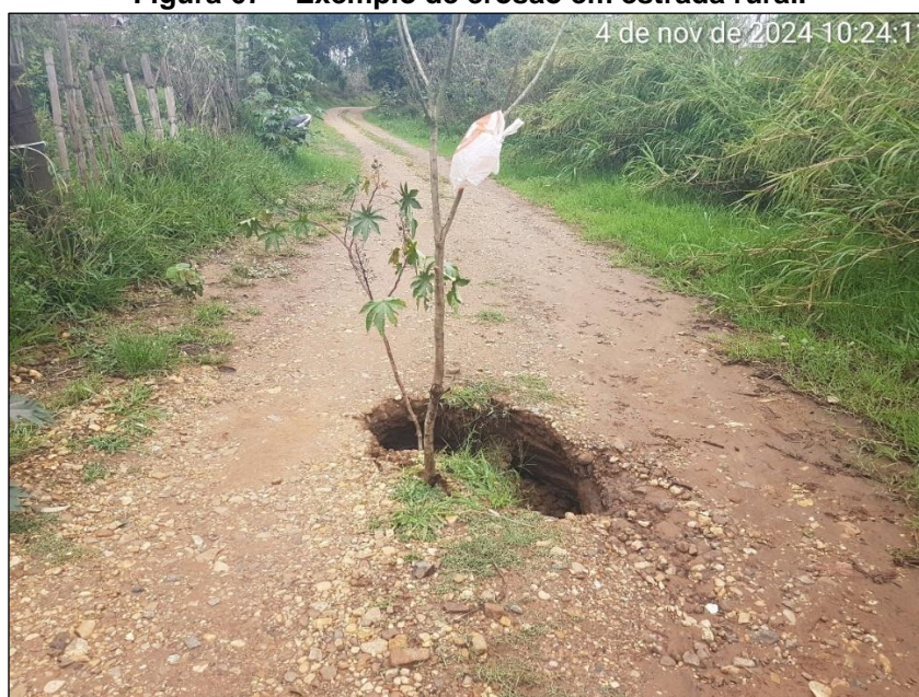
Figura 67 – Exemplo de erosão em estrada rural.
