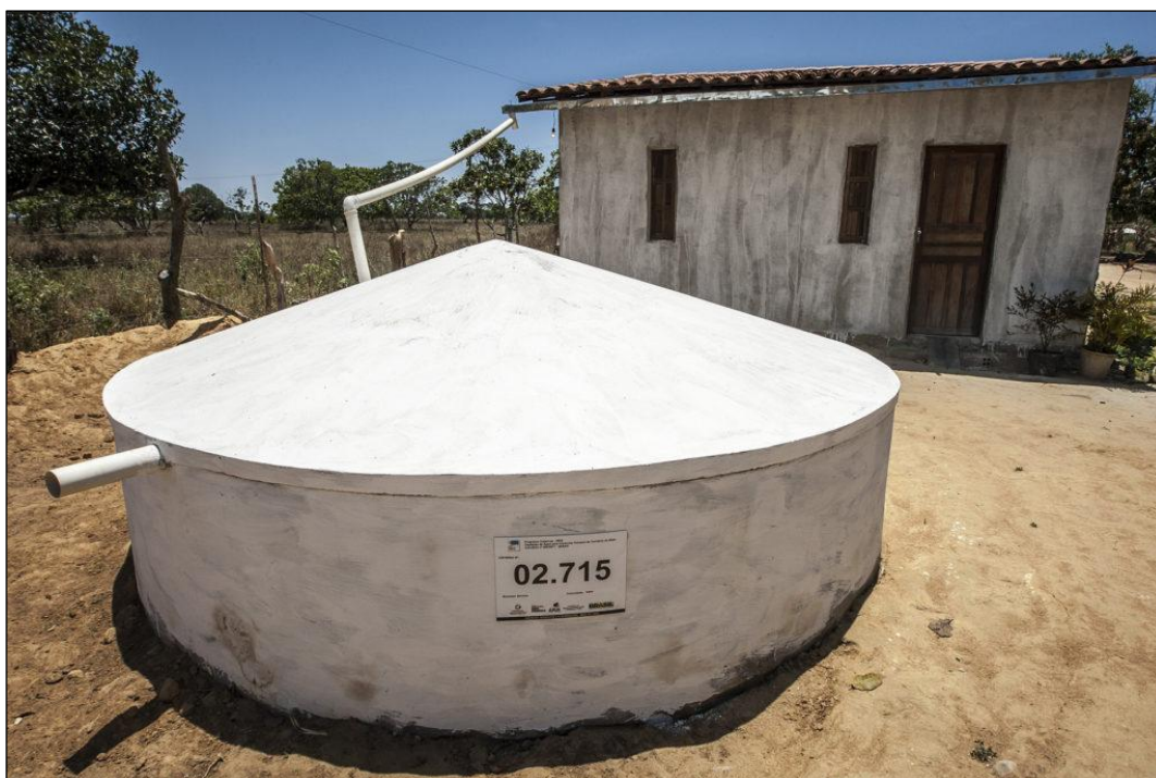
Figura 70 - Cisterna de superfície para armazenamento de águas pluviais.
